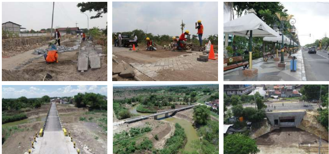
Gambar 2.2 Pembangunan Jalan dan Jembatan
